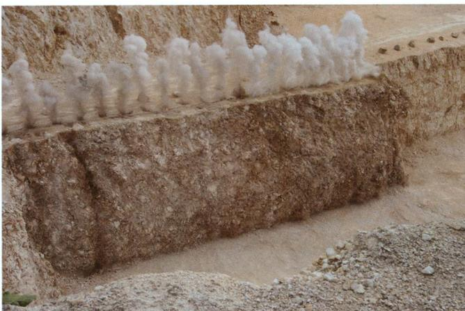
Bild 1. Strossen-Sprengung im Festgestein (Sprewa Sprengmittel GmbH)
